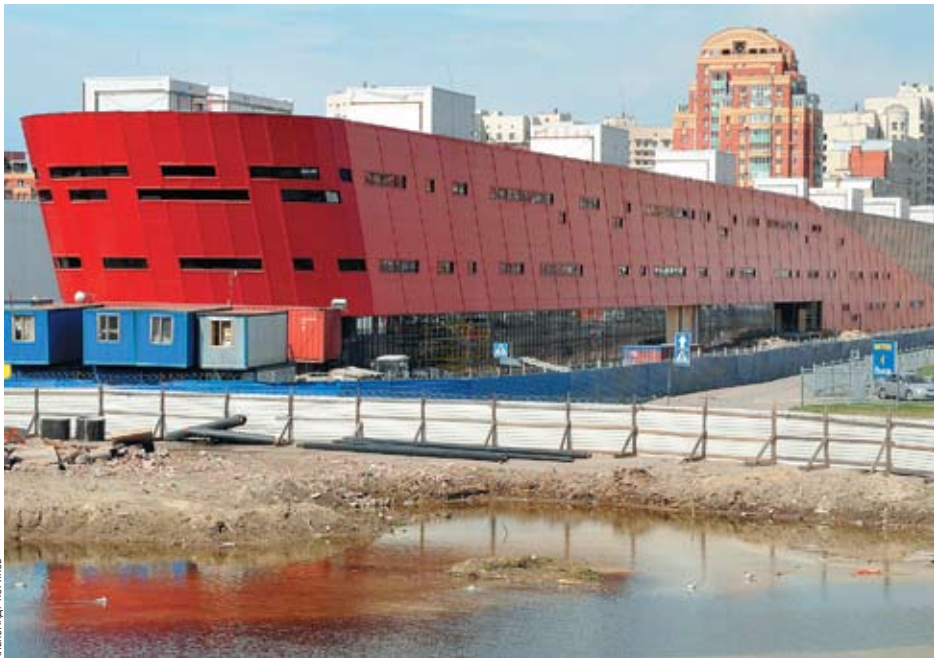
В ПРИМОРСКОМ РАЙОНЕ НАБЛЮДАЕТСЯ ПЕРЕНАСЫЩЕНИЕ ТОРГОВЫМИ КОМПЛЕКСАМИ. ВОЗМОЖНО, В ТОМ ЧИСЛЕ И ПОЗТОМУ ЗАВЕРШИТЬ НЕКОТОРЫЕ ПРОЕКТЫ ТАМ НЕ УДАЕТСЯ УЖЕ НЕСКОЛЬКО ЛЕТ
