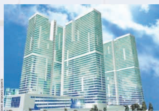
ЖСК «АВЕНЮ, 77» Северное Чертаново, вл. 1 А
